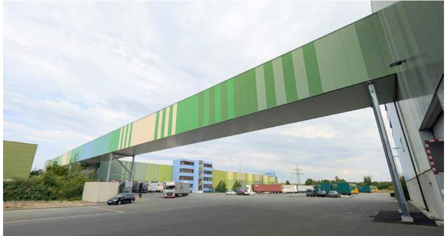
Der 2025 umgesetzte Bau dieser Verbindungsbrücke zwischen zwei Werkshallen der Sandler AG in Schwarzenbach ist Teil der Automatisierungsinitiative.
